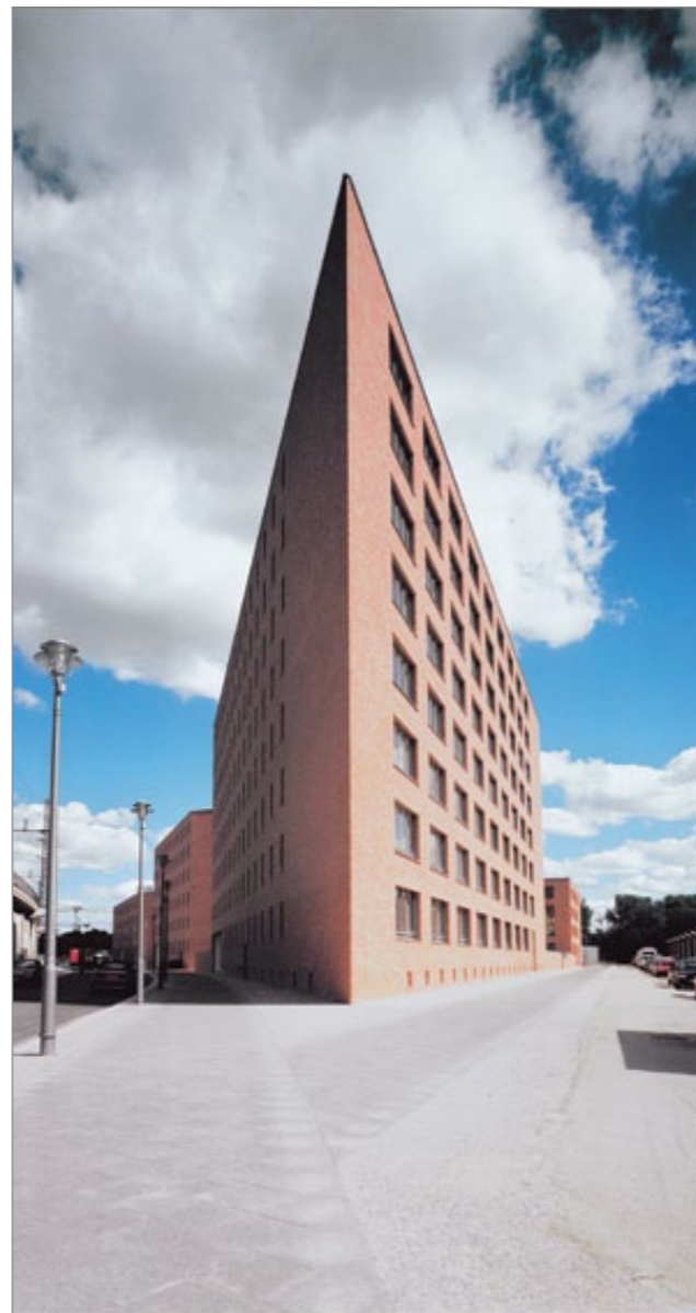
Bauprojekt „Schlange“ in Berlin-Moabit
